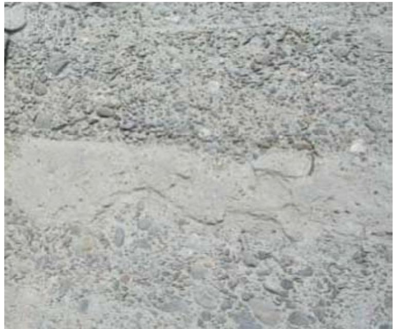
**Modalità ispettive:** *Osservare con attenzione gli elementi in cemento le asperità dell'elemento in calcestruzzo ricercando gli aggregati liberi dalla matrice cementizia, fino all'osservazione della formazione di concavità nell'elemento in esame.*
