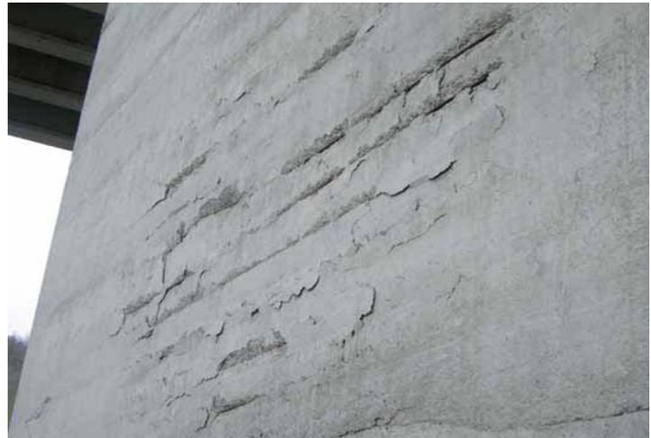
**Modalità ispettive:** *Osservare con attenzione gli elementi in cemento e valutare l'esposizione delle armature per estensione e profondità.*
