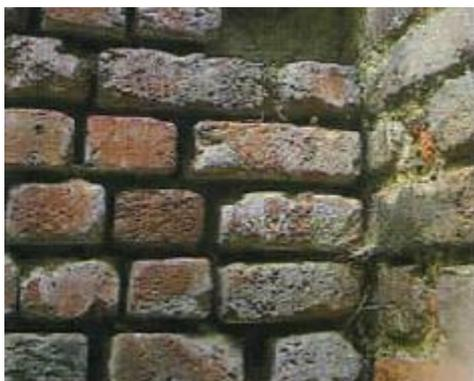
*Il difetto è caratterizzato dalla disgregazione dei giunti di malta che genera perdita di coesione e aderenza fra il materiale lapideo.*
