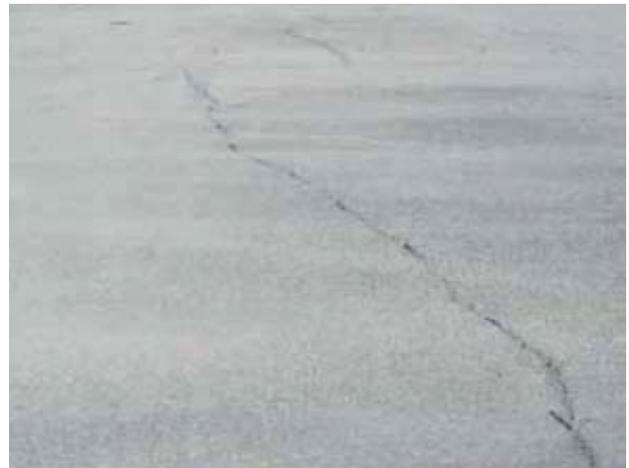
**Procedure e strumenti:** In presenza di fenomeni di ritiro e fessurazione è opportuno documentare fotograficamente il fenomeno e valutare le dimensioni delle fessure. Attenzione: nel caso in cui le fessure misurino più di alcuni millimetri è doveroso valutare se il fenomeno è riconducibile ad azioni esterne che siano diverse da quella in esame. Potrebbe a quel punto essere opportuno l'utilizzo di fessurimetri.
