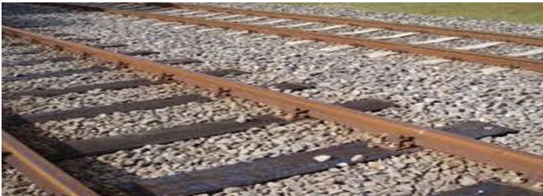
Figura 4: Traversa in legno in opera
