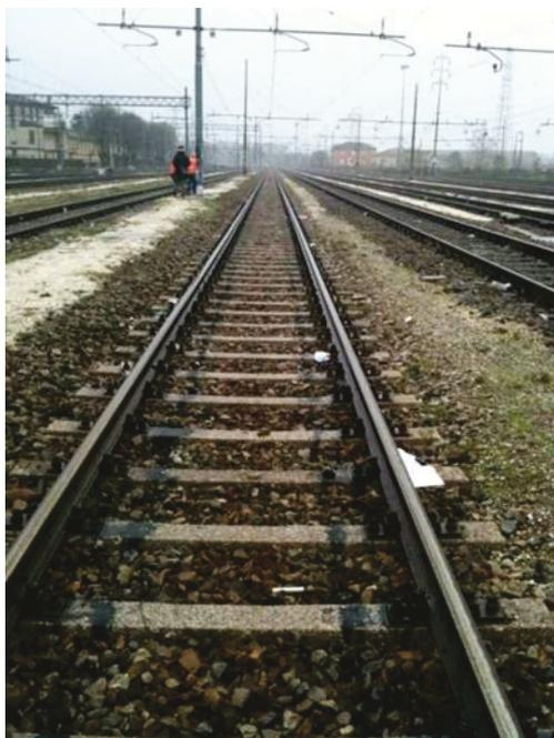
*Figura 6: Binario attrezzato con Traverse in cap*
