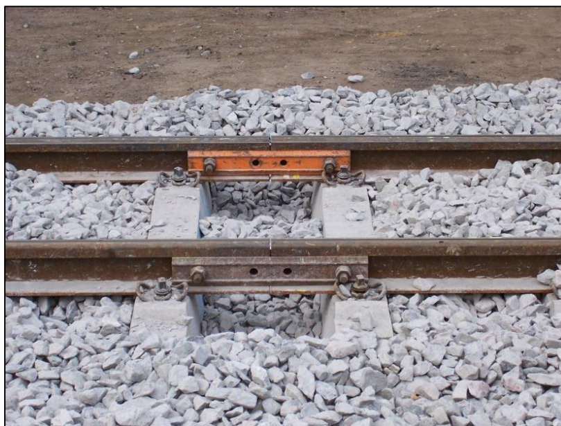
Figura 8: Giunzione sospesa
