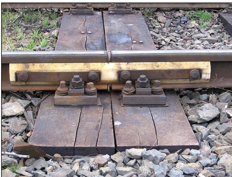
Figura 7: Giunzione appoggiata
