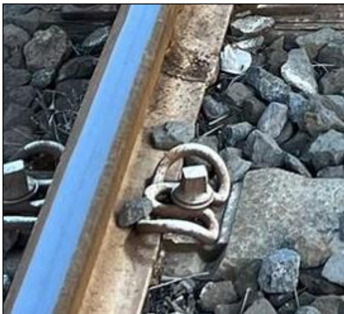
Figura 6: Sistema di attacco diretto elastico
