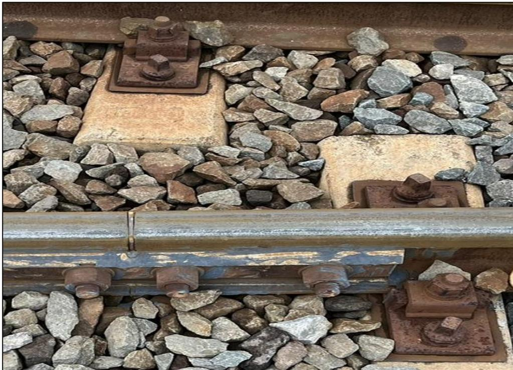
Figura 7: Attacco indiretto con piastre 330 su capv
