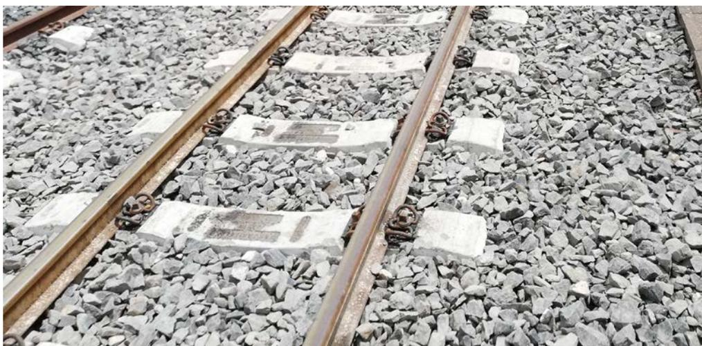
Figura 5: Attacco diretto elastico Vossloh W14
