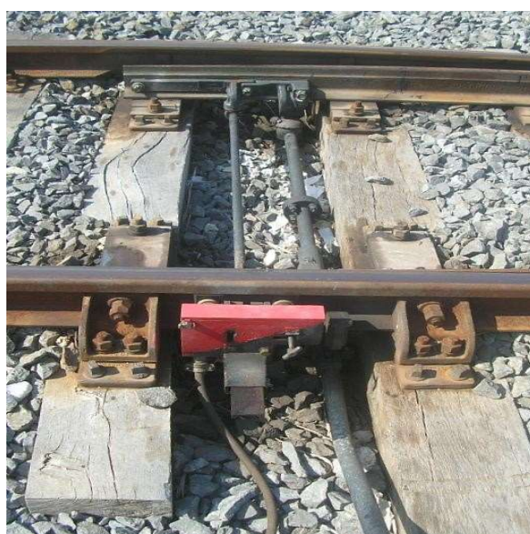
Figura 3:Fermascambio con CEF
