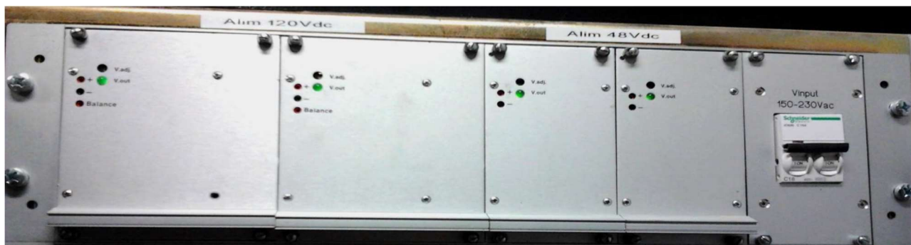
Figura 5: Sistema di Alimentazione
