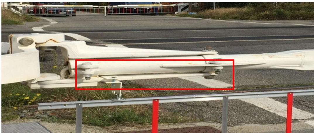
Figura 9: Barriere da PL munite di grembiuli
