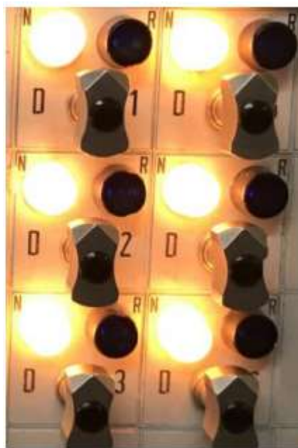
Figura 9: Maniglia per la manovra individuale deviatori
