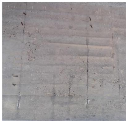
**Descrizione:** I vespai o nidi di ghiaia sono difetti molto evidenti che compromettono la continuità superficiale del calcestruzzo possono interessare zone estese o essere localizzati in zone limitate della superficie degli elementi strutturali. Essi comportano la presenza di zone non omogenee sulle superfici degli elementi a causa dell'esposizione degli inerti più grossi di calcestruzzo, che, nei casi più gravi, sono asportabili manualmente.
