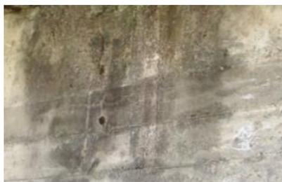
**Descrizione:** Il dilavamento e/o l'ammaloramento del calcestruzzo sono dovuti alla percolazione di acque superficiali e si manifesta prevalentemente sulle superfici degli elementi. Per dilavamento si intende l'erosione dello strato superficiale di materiale dovuto al passaggio frequente di acqua, mentre con il termine ammaloramento ci si riferisce ai fenomeni di rigonfiamento superficiale del calcestruzzo, scagliamento, perdita di coesione, ecc.
