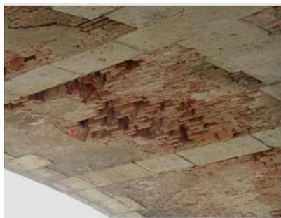
**Descrizione:** Il difetto è caratterizzato dalla perdita di materiale lapideo e riduzione della sezione resistente del tessuto murario dovuto ad azioni meccaniche esterne (urti, esplosioni), o per usura o per effetto di fenomeni chimici.
