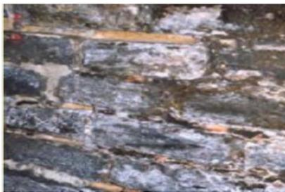
**Descrizione:** Il difetto si manifesta con l'apertura di lesione che possono seguire un andamento a zig-zag (irregolare) lungo i giunti di malta delle murature a blocchi causando la perdita di materiale e l'indebolimento dell'opera.
