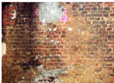
**Descrizione:** Deterioramento della superficie della muratura con perdita di sezione resistente. Il difetto è anche riconoscibile dalla differente colorazione che hanno la superficie intatta e quella degradata.
