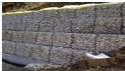
**Descrizione:** Gli scorrimenti e/o il ribaltamento sono dovuti principalmente a cause esterne e/o eventi straordinari (frane, smottamenti, sisma) che alterano la normale configurazione dell'elemento. Problemi alla resistenza dell'opera possono altresì verificarsi in seguito ad un'errata progettazione o esecuzione dell'opera.
