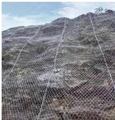
**Descrizione:** Il difetto è dovuto principalmente sia alla vetustà degli elementi sia all'azione aggressiva degli agenti esterni che comportano fenomeni di rottura/distacco degli ancoraggi sia sommitali che laterali e/o rottura delle reti. Problemi alla resistenza dell'opera possono altresì verificarsi in seguito ad un'errata progettazione o esecuzione dell'opera.
