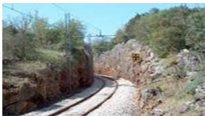
**Descrizione:** Le trincee possono presentare il fenomeno del dilavamento o scivolamento verso la base del versante, che avviene per deformazioni di taglio entro uno spessore limitato di materiale.
