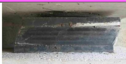
**Descrizione:** Il fenomeno si riferisce a scorrimenti eccessivi degli apparecchi di appoggio sul piano orizzontale, lungo l'asse trasversale o longitudinale del piano stradale. Essi provocano perdita di forma delle sezioni nel caso di lastre non vulcanizzate o distacco e scorrimenti tra gli strati di neoprene e i lamierini di acciaio, nel caso di lastre vulcanizzate.
